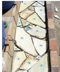
DIYで作成途中の庭の水栓の水受け
